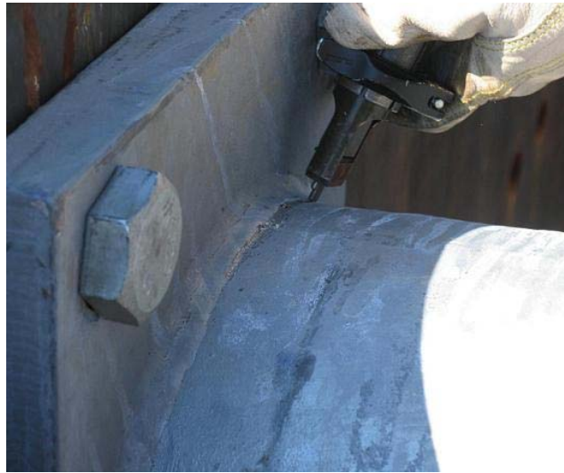
Figure 5.3.2.3 Application of UIT to a Mast Arm Weld Toe
