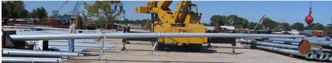
Figure 5.3.1.6 Entire Loaded and Fixed Mast Arm UIT Setup
