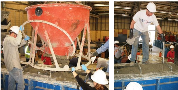
(d) Place concrete
